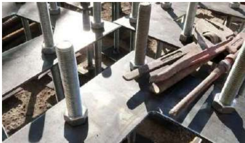
Thi công trong xây dựng
